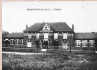
L'école © Mairie de Riencourt-lès-Cagnicourt
